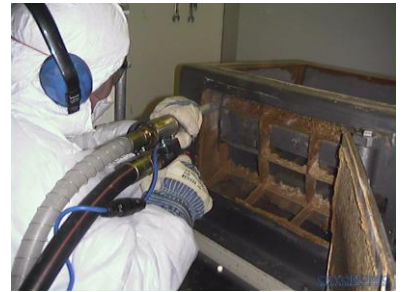
ทำความสะอาดคราบ ซีเมนต์และคาร์บอนที่ ติดตามอุปกรณ์
