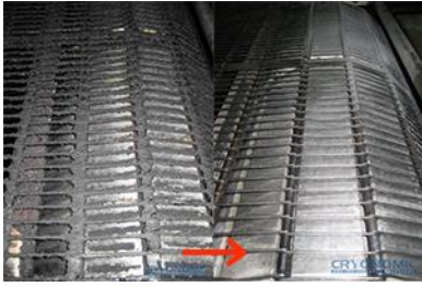
ทำความสะอาดระบบ ลำเลียงสายพานของ เตาเผา
