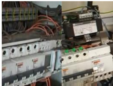
ทำความสะอาดแผงสวิตช์ไฟฟ้า (Electrical switchboard cleaning)
