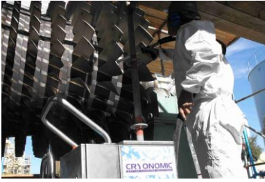
ทำความสะอาดเทอร์ไบน์ (Turbines)
