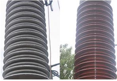
ทำความสะอาดฉนวนไฟฟ้า (Insulator)
